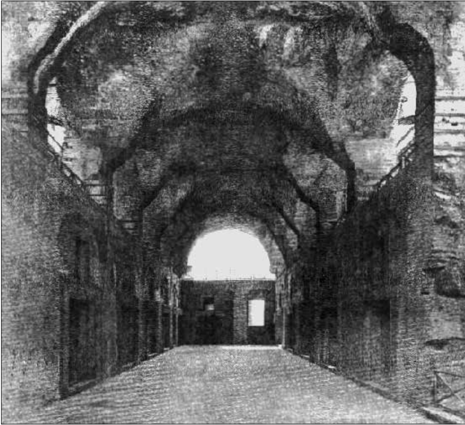
„Römisches“ Gewölbe aus Beton: Die Haupthalle der Traian-Märkte wird um das Jahr 110 datiert.
