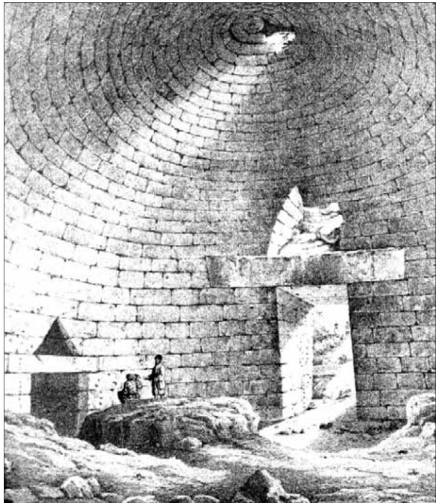
Auch ohne Beton hat man bienenkorbformige Kuppeln gebaut: das fünfzehn Meter hohe Innere des Schatzhauses des Atreus in Mykene (nach anderen Annahmen: des Atreus-Grabes), datiert in das -14. Jahrhundert.
